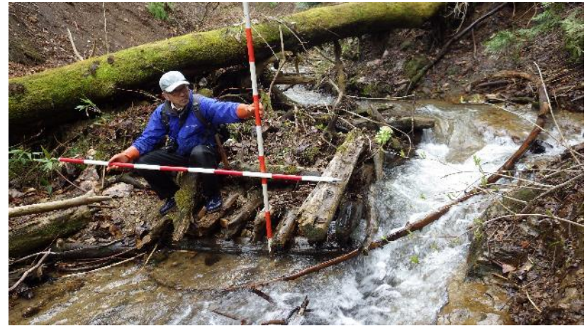
1916年(大正5年)施工の木製ダムの破壊の例
