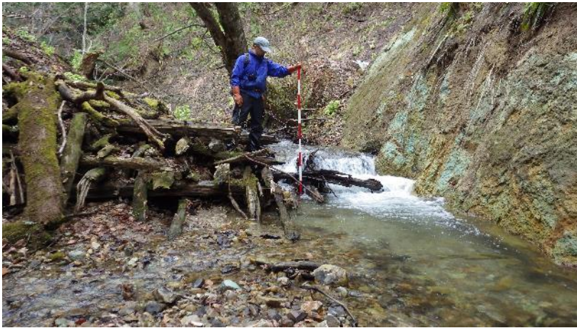
1916年(大正5年)施工の木製ダムの破壊の例
